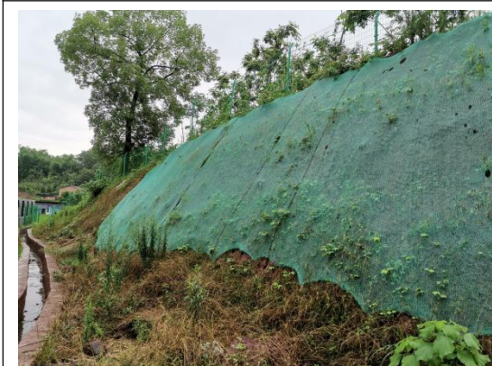
云龙机场管理站绿化及站外排水
