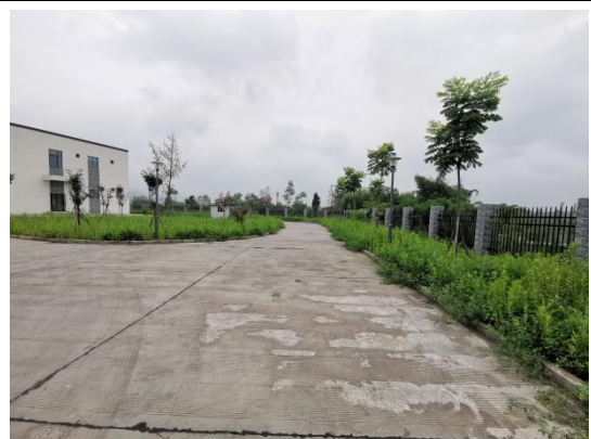
方洞收费管理站站内排水及绿化
