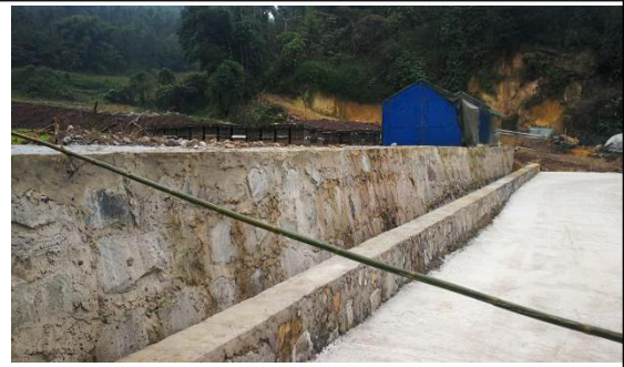
1#渣场下游挡渣墙现状 (拍摄于 2019 年 11 月)
