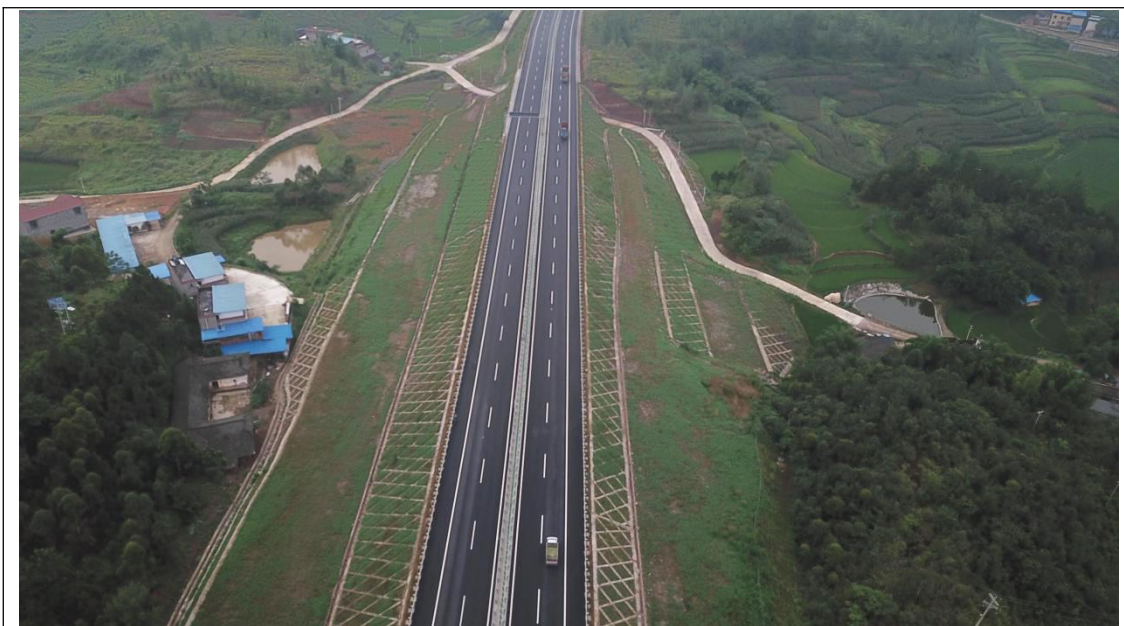
隧道出口端路面及挖填边坡段防护
