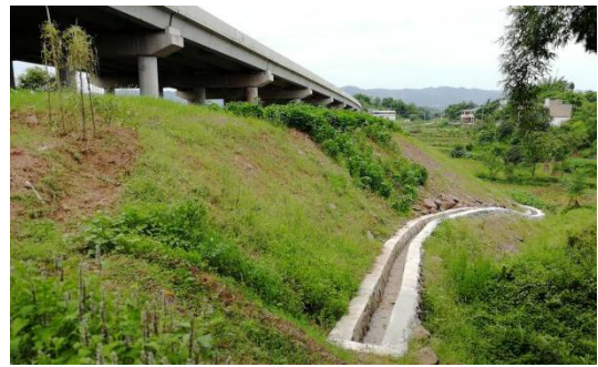
2#渣场周边排水现状 (拍摄于 2019 年 11 月)
