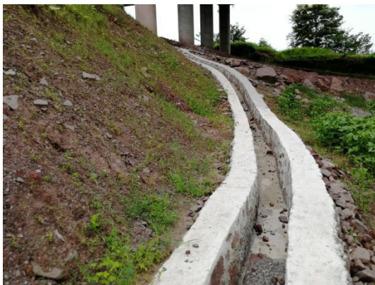
2#渣场周围排水现状 (拍摄于 2019 年 11 月)
