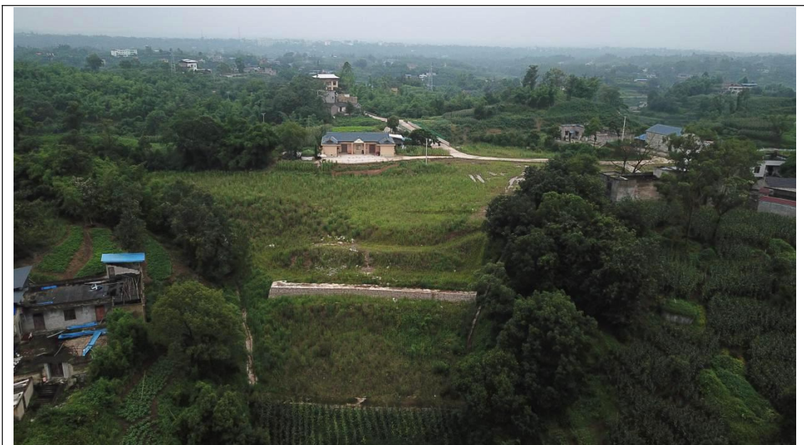
5 分部 K162+800 道路右侧弃渣场 (6#渣场——已移交当地政府)
