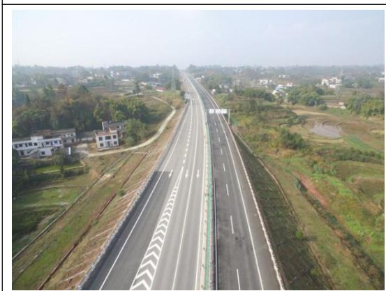
K158+600 段填方段护坡及排水沟
