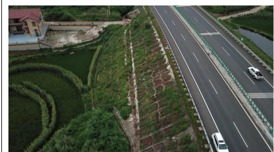
K155+300 段填方路基边坡防护（左）
