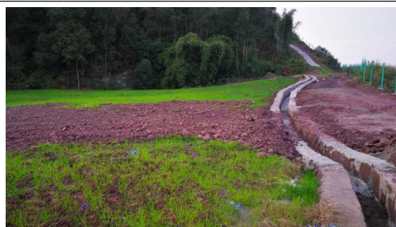
3#渣场渣顶排水及绿化 (拍摄于 2019 年 11 月)
