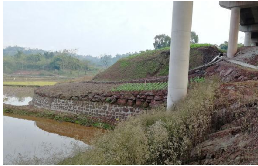
2#渣场下游挡渣墙现状 (拍摄于 2019 年 11 月)
