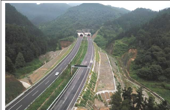
隧道进口端填方路基边坡防护
