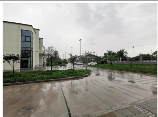
云龙机场管理站站内绿化及排水
