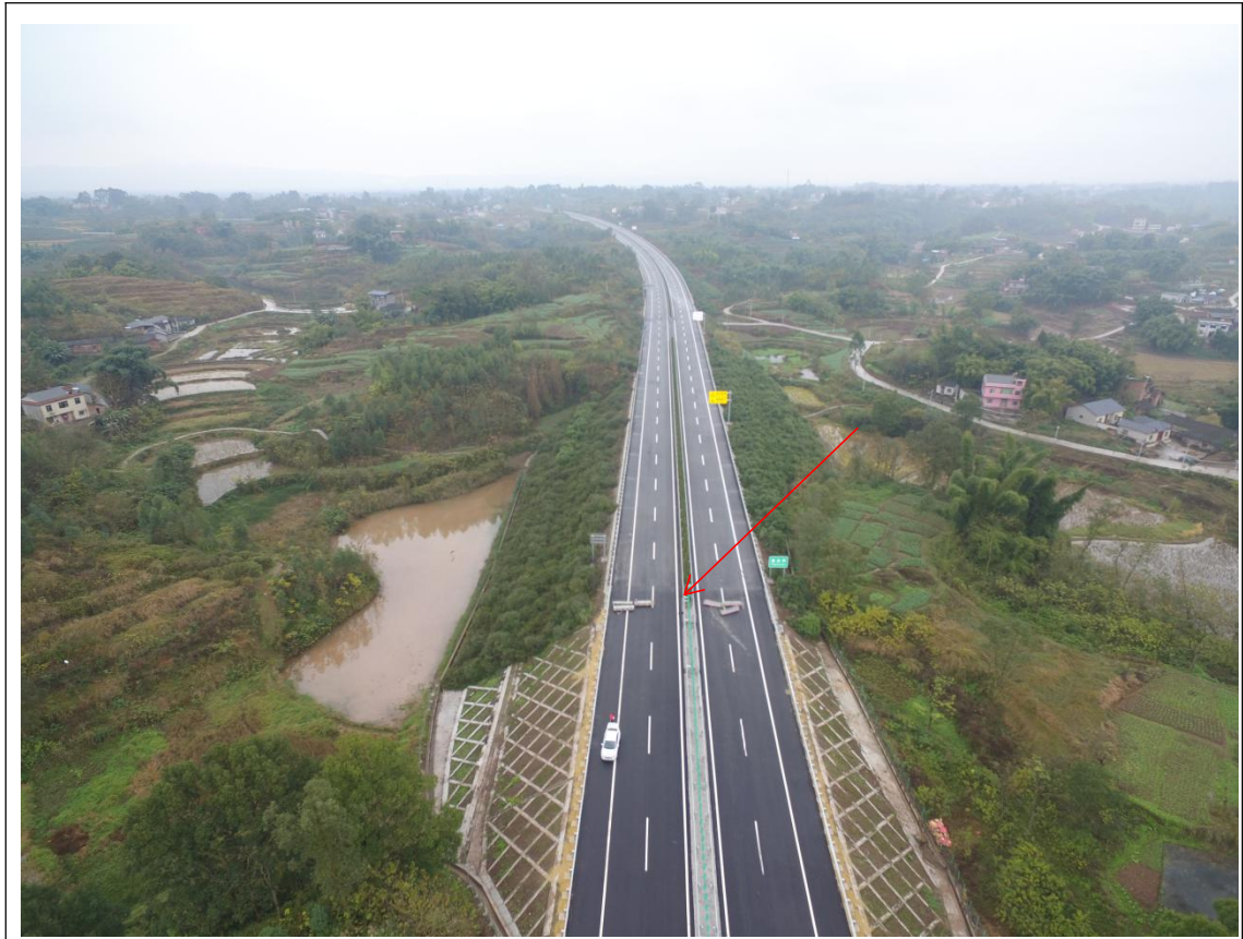
主线起点及填方防护
