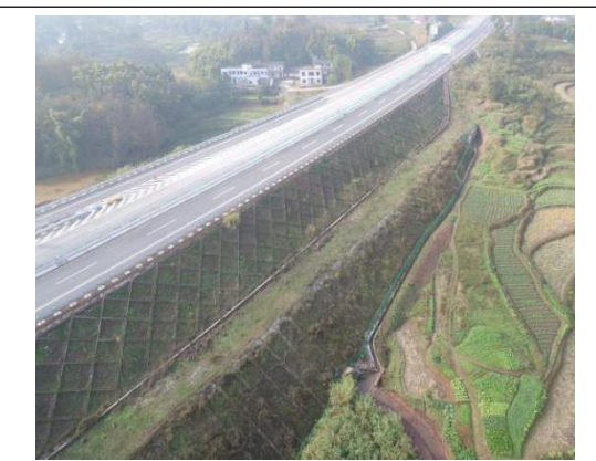
路基左侧填方边坡护坡及排水
