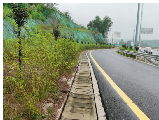
进站道路边沟及绿化现状
