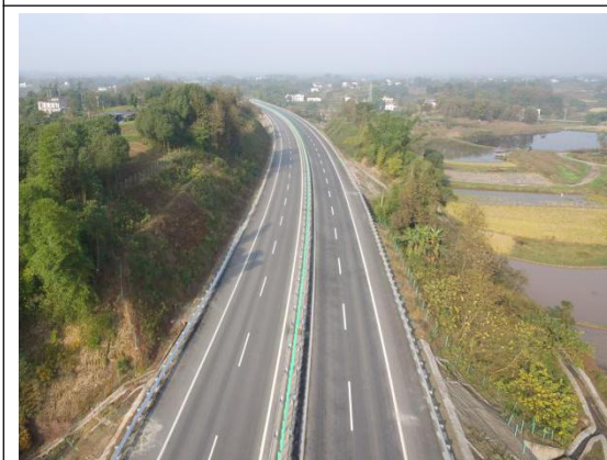
K162+600 挖填路段边坡防护
