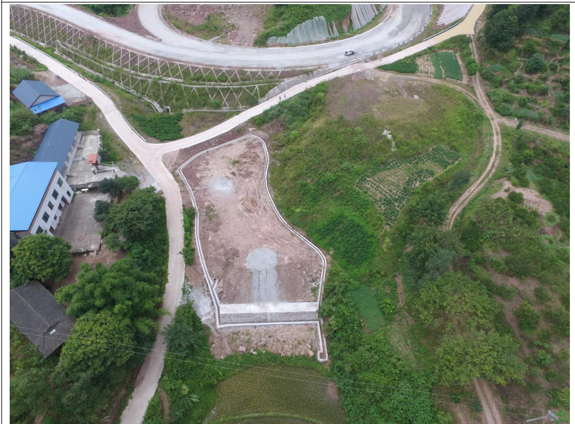
4 分部奇峰互通弃渣场 (5#渣场)
