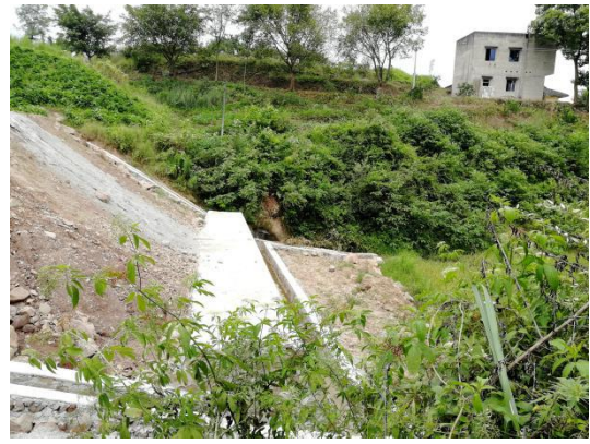
5#渣场下游挡墙及排水、泥沙现状
