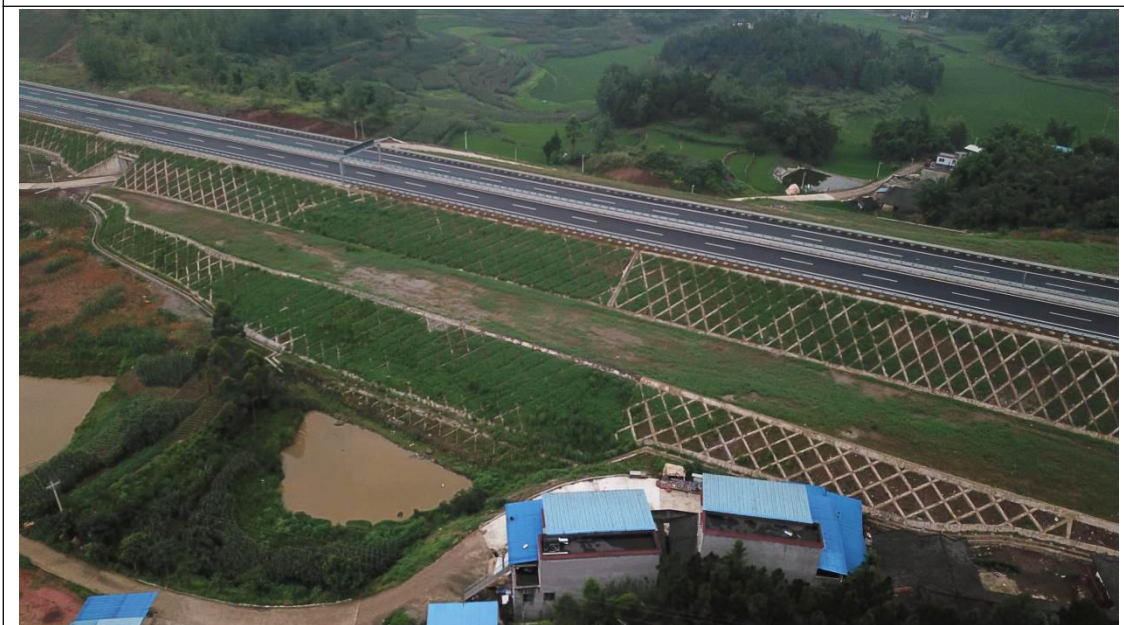
隧道出口端路面及挖填边坡段防护
