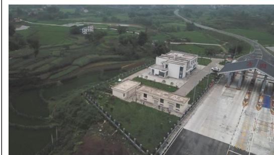
方洞收费管理站全貌
