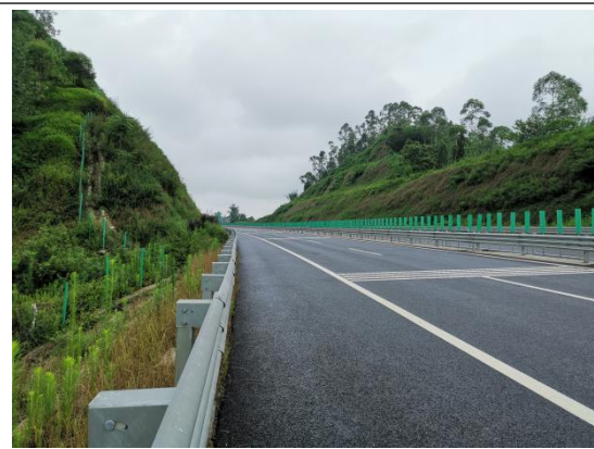
奇峰互通匝道两侧边坡绿化及排水
