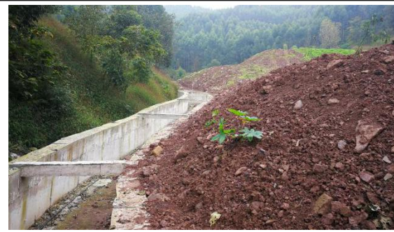
1#渣场左侧改沟现状 (拍摄于 2019 年 11 月)
