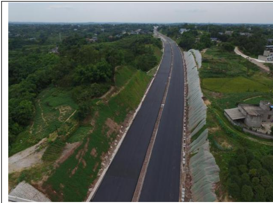
路堤填筑边坡框格护坡
