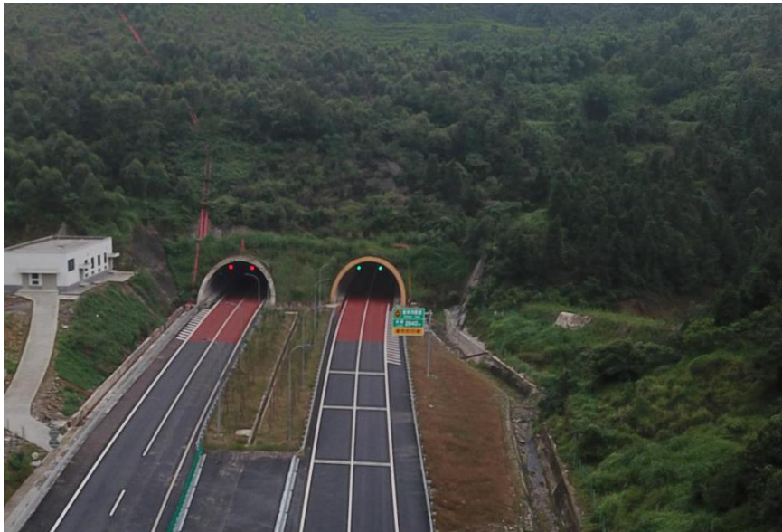
隧道出口端洞脸、洞门及中央分隔带防护
