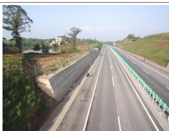
K166+500 段护脚墙及植草护坡
