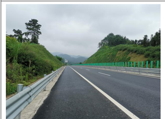
隧道出口端路堑边坡边坡防护
