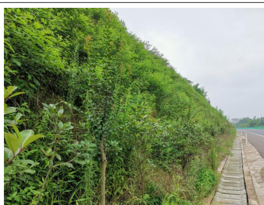
挖方段路基绿化
