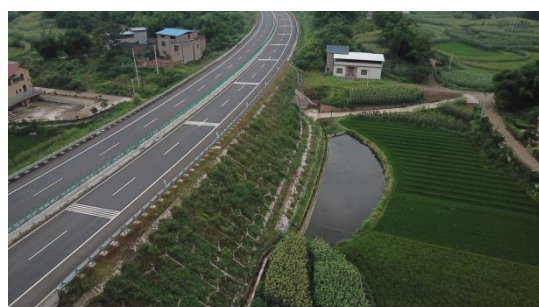
K155+300 段填方路基边坡防护（右）
