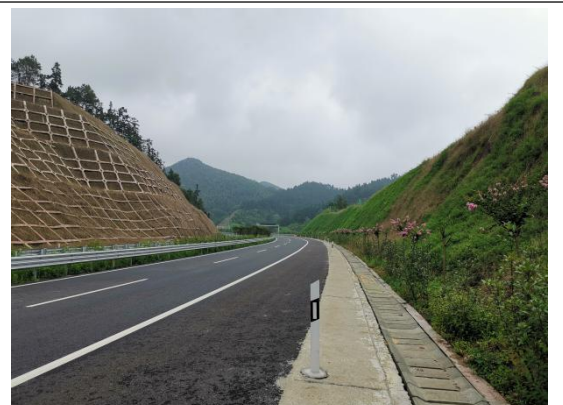
隧道进口端路堑边坡边坡防护
