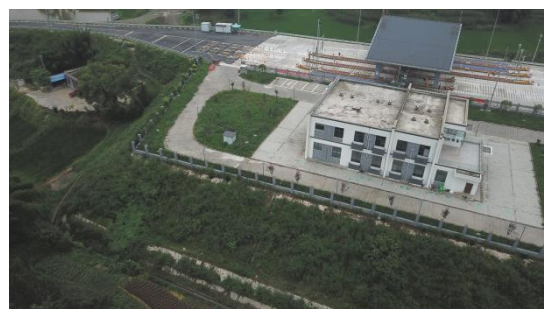
方洞收费管理站站外边坡绿化
