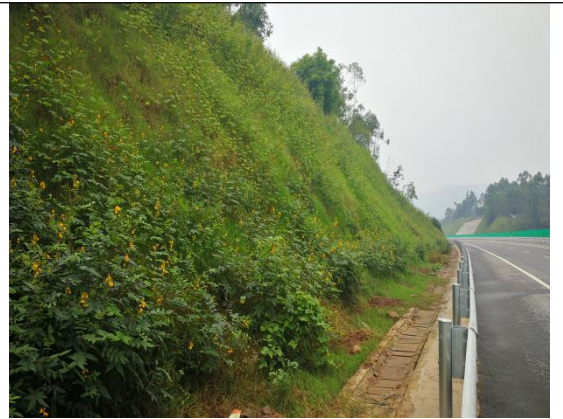
路堑边坡植草绿化及排水边沟
