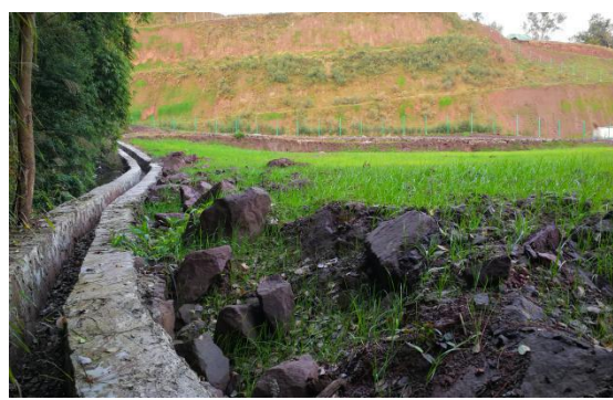
3#渣场周围排水及绿化现状 (拍摄于 2019 年 11 月)
