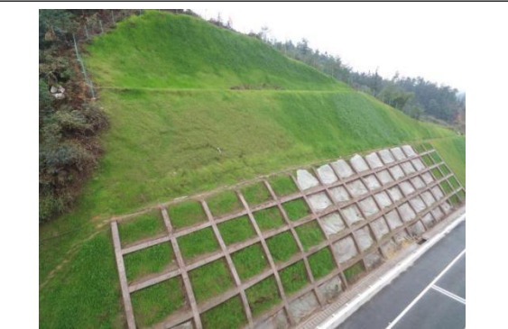
隧道进口端挖方路基边坡防护
