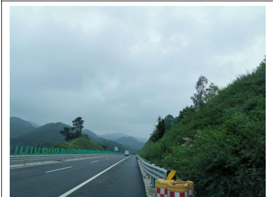
隧道进口端路堑边坡边坡防护
