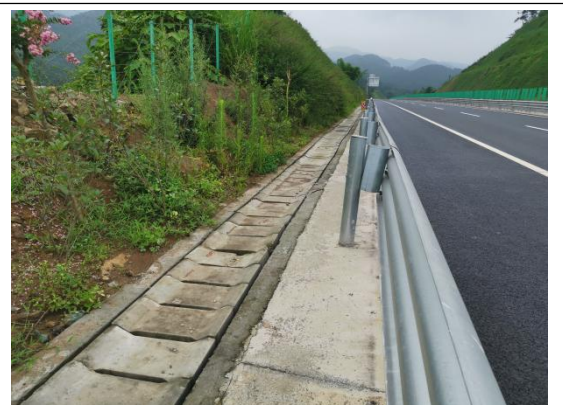
隧道出口端路基外侧边沟
