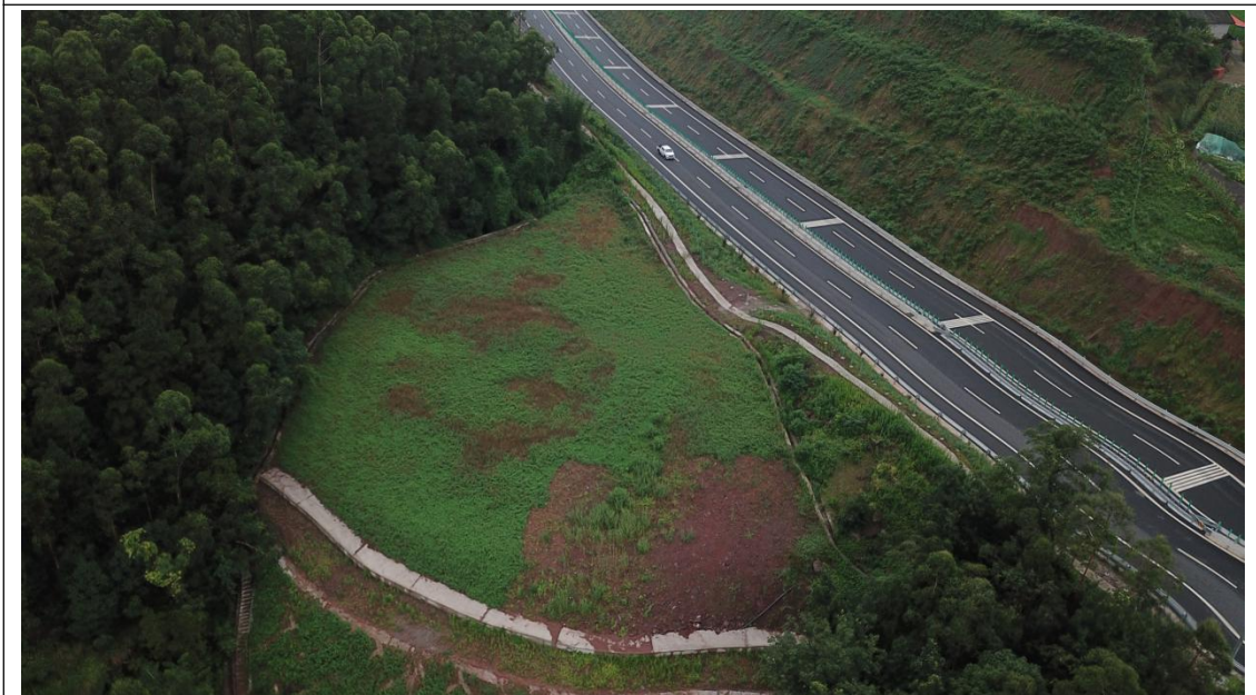
4 分部 K156+100 路基右侧渣场 (3#渣场)
