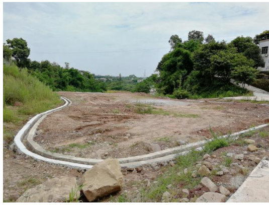
5#坡顶汇水沟现状
