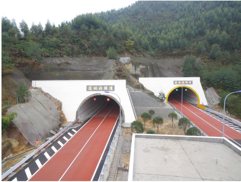
隧道进口端洞脸及洞门防护
