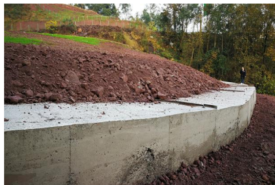
3#渣场挡墙现状 (拍摄于 2019 年 11 月)
