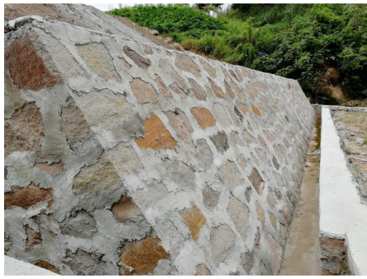
5#挡渣墙及排水沟现状
