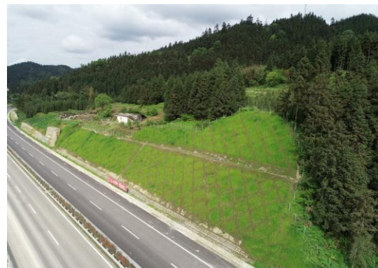
路基工程坡面植物防护
