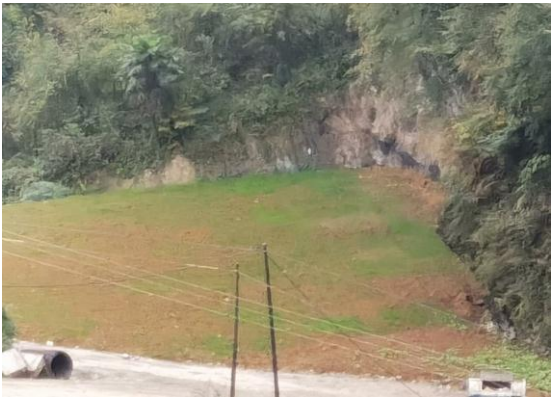
施工场地区绿化
