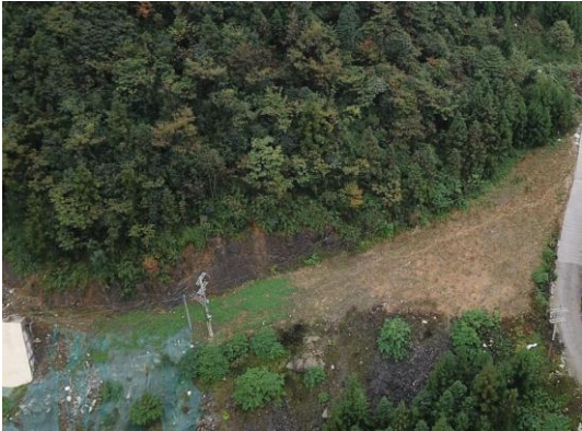
施工便道绿化
