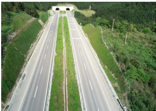
路基工程坡面植物防护
