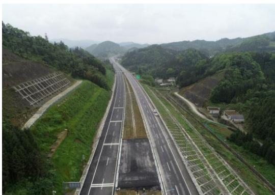
路基工程坡面植物防护
