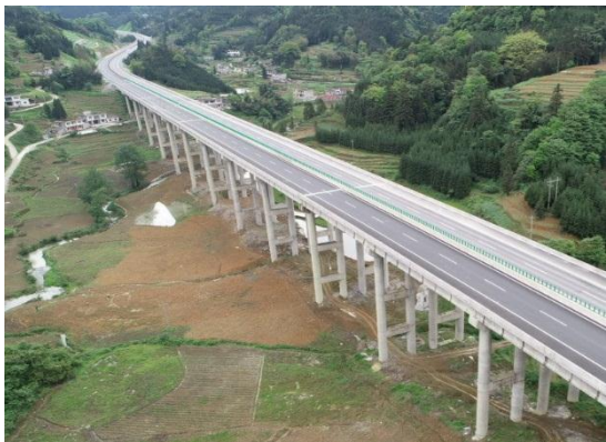
桥涵工程区绿化
