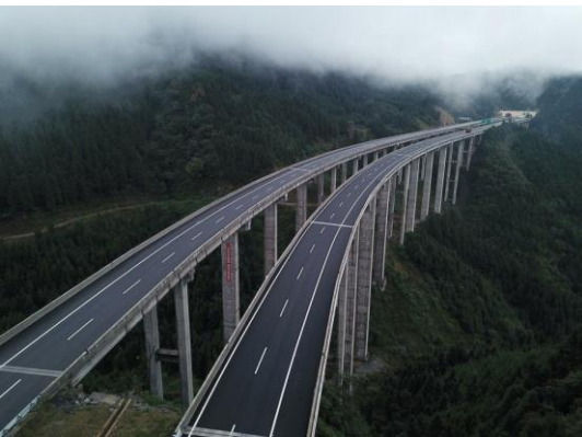
桥涵工程区绿化
