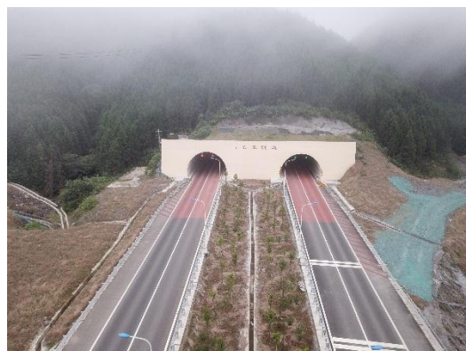
6#监测点-马长寨隧道出口
