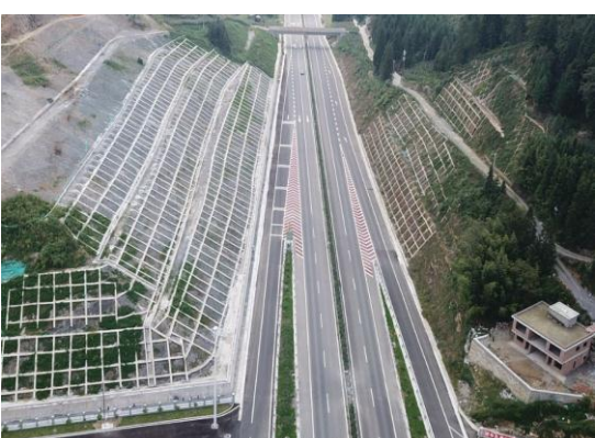
浆砌石骨架护坡
