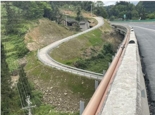
施工便道绿化
