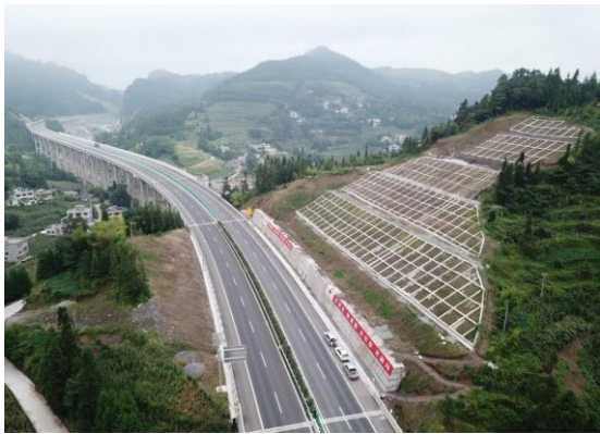
浆砌石骨架护坡
