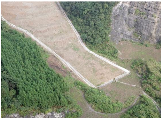
K0+600 弃渣场挡渣墙
