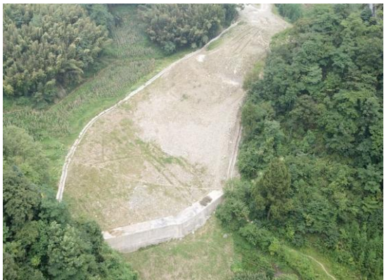
K20+608 弃渣场挡渣墙
