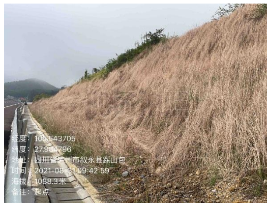
2#监测点挖方路基边坡
