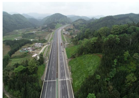
路基工程坡面植物防护
