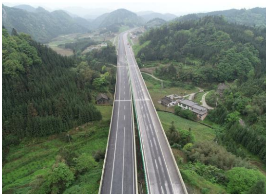
桥涵工程区绿化
