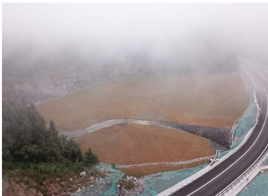
K8+500 左侧弃渣场排水沟
