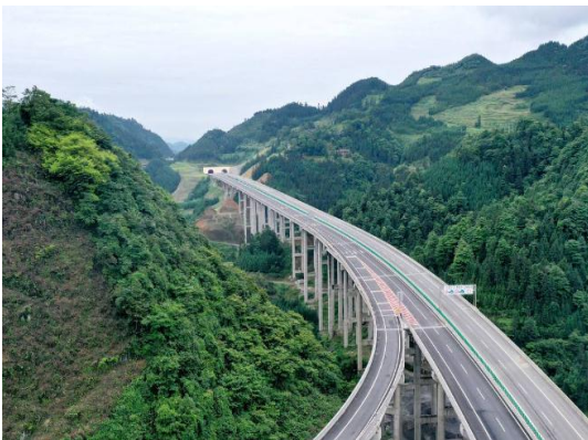
桥涵工程区绿化
