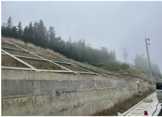
浆砌石骨架护坡
