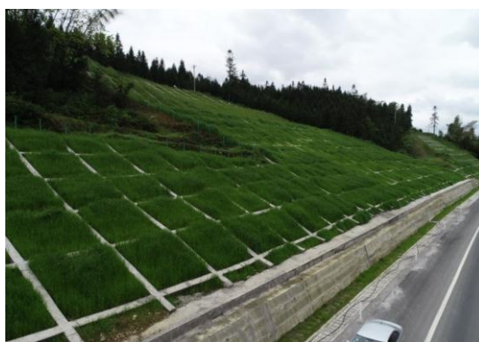
路基工程坡面植物防护
