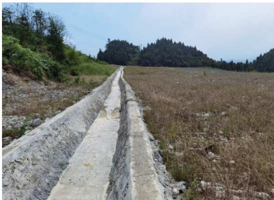
K27+000 弃渣场排水沟
