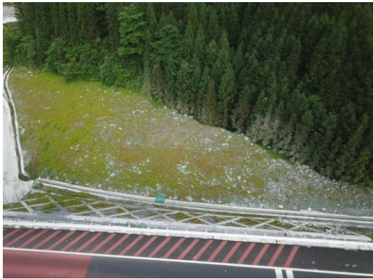
施工场地区绿化
