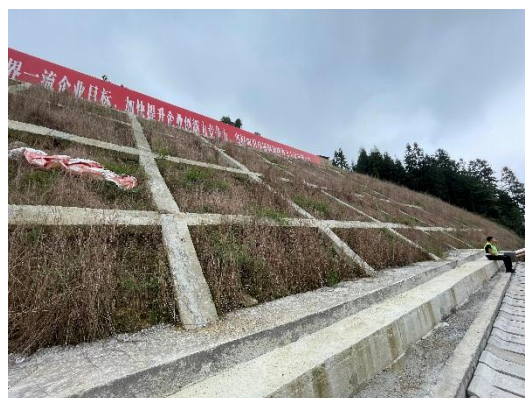
4#监测点挖方路基边坡
