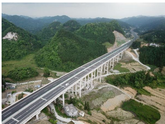
5#监测点瓦窑坝大桥
