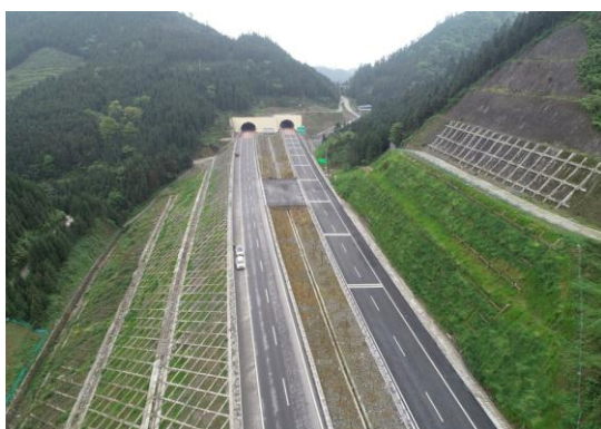
路基工程坡面植物防护
