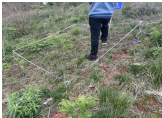
7#监测点 填方路基边坡
